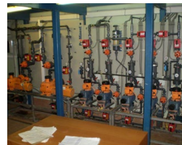
Дозирующая станция ProMinent, выполненная на основе насосов-дозаторов Sigma, ГУП «Водоканал Санкт-Петербурга»
